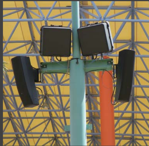
▲メインゲートやアトラクションの入口に設置されている CBT Series。低域用スピーカーの「CBT 70JE-1」は植え込みの中にも配置されている。
