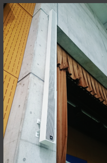
▲ 導入された JBL PROFESSIONAL のコラム型パワード・スピーカー Intellivox [Ivx-DS280]
