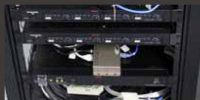
▲ Gefen「EXT-HD2IRS-LAN」 送信機 2 台、受信機 5 台でシステムを構築
