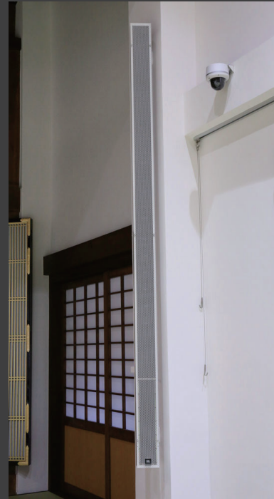
▲向かって右側の壁に設置された「lvx-DSX280HD」。柱と一体化し、スピーカーがあることがほとんど分からない。
