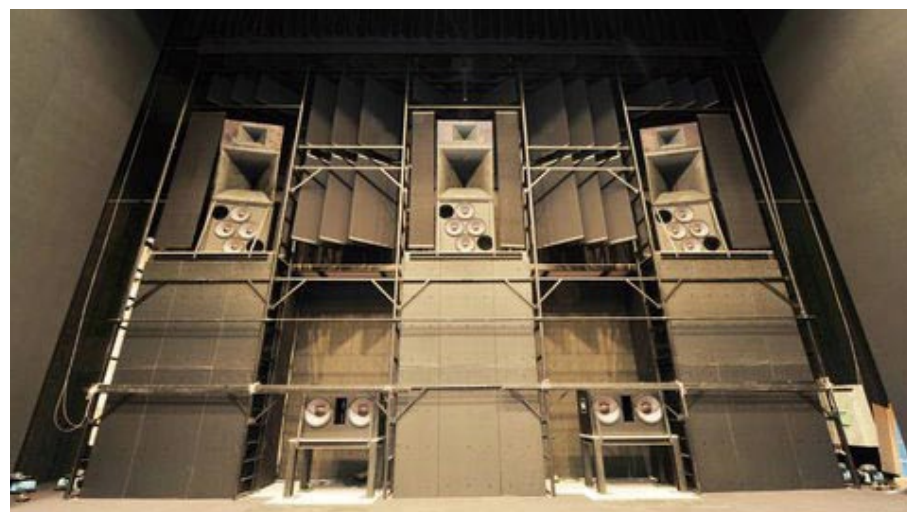
シアターのスクリーン奥にある 3-Way スピーカー “5674” とサブウーファー “4642A”
