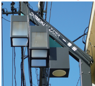
照明機器の収容ボックスと同様のボックス(右下)に、放送用スピーカーとしてJBL PROFESSIONAL “Control 24CT”が収められている。
