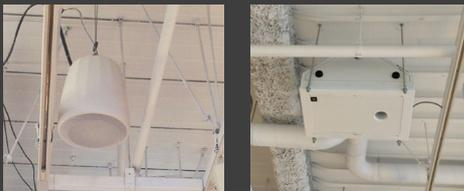
▲(左)Control 65P/T。(右)“Control SB-2”サブウーファー。白く塗装して、天井から吊り下げています。
