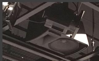
◀ 天井には舞台を使用せず、多目的スペースとして利用する場合の拡声用として AC2212/00 を 12 本設置。指向角度が  $100^{\circ} \times 100^{\circ}$  で、広いエリアを均一な音質でカバーします。
