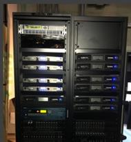
◀ パワーアンプに多チャンネルモデルを使用することで設置スペースを抑えています。
