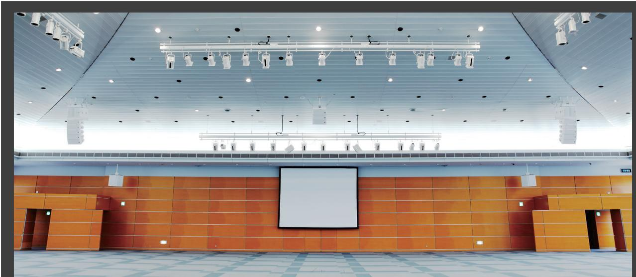
▲両サイドは 3-Way フルレンジの ViRAY × 5 とセンサーコントロールド・サブウーファー SCV-F × 1 のシステム。間口が広いので、センターにも ViRAY × 3 のシステムが配置されています。コンパクトながら高出力。特注の白塗装 (RAL9003) は、天井に同化して違和感がありません。
