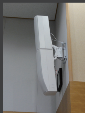
▲取付金具 壁への取付は、スピーカーの上下左右の角度調整が可能な純正の金具を利用。「金具のカスタム制作が不要で、予算を節約できました。」とご満足いただきました。
