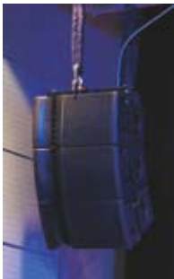
▲舞台 天井から小型ラインアレイスピーカー (VRX928LA × 3台) を両端に フライング。舞台袖にはモニター用の EON510 を設置。
