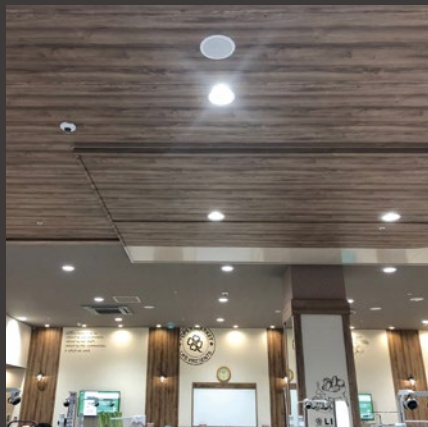
▲102 本もの「Control 24CT Micro」を配置することで、包み込むような BGM とクリアなアナウンスを実現した。
