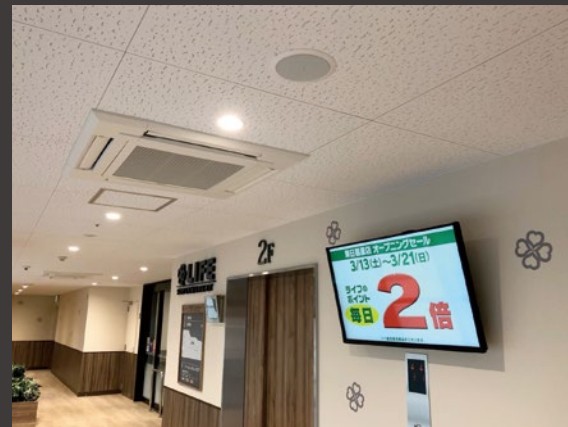
▲102 本もの「Control 24CT Micro」を配置することで、包み込むような BGM とクリアなアナウンスを実現した。
